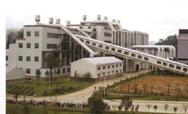
33000kVA工业硅炉
