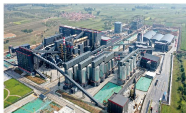
75000kVA全密闭铬铁炉
