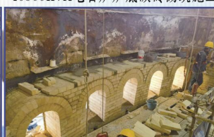
300T/D双梁石灰窑施工现场
