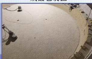
54000KVA电石炉内衬砌筑
