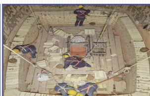
600TPD吨双梁石灰窑施工
