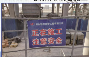
185T/D石灰窑施工现场
