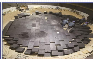
40500KVA电石炉炉底碳砖砌筑施工
