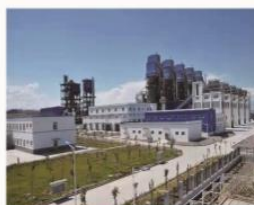
新疆博乐天博辰业8*600T 石灰窑配套除尘系统
