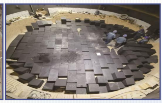
40500KVA电石炉炉底碳砖砌筑施工
