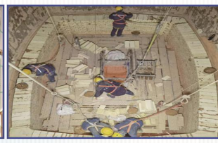
600TPD吨双梁石灰窑施工
