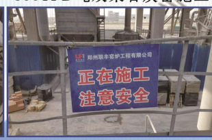
185T/D石灰窑施工现场
