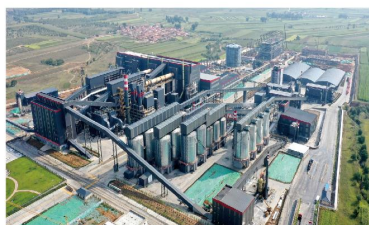
75000kVA全密闭铬铁炉
