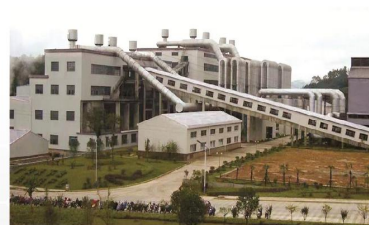
33000kVA工业硅炉
