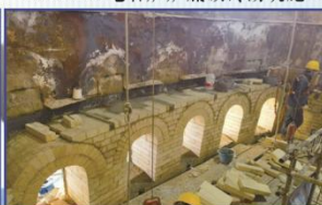
300T/D双梁石灰窑施工现场
