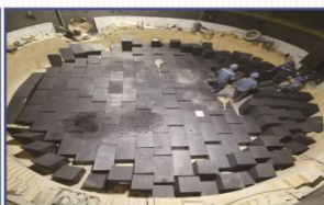
40500KVA电石炉炉底碳砖砌筑施工
