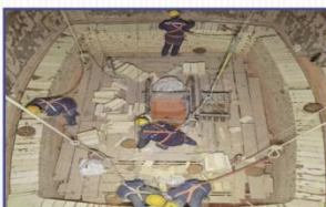
600TPD吨双梁石灰窑施工
