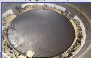
48000KVA电石炉炉底碳砖施工
