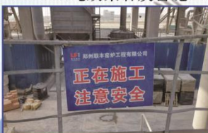
185T/D石灰窑施工现场
