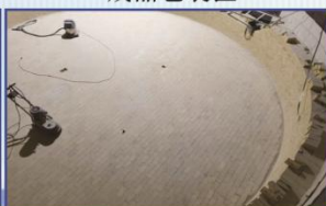
54000KVA电石炉内衬砌筑
