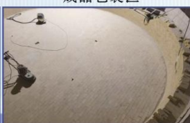
54000KVA电石炉内衬砌筑
