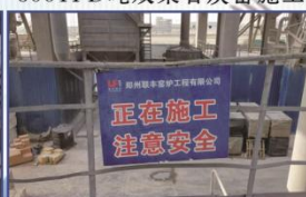
185T/D石灰窑施工现场
