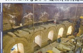
300T/D双梁石灰窑施工现场
