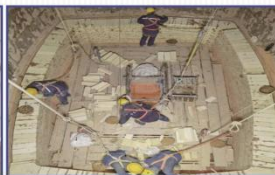
600TPD吨双梁石灰窑施工
