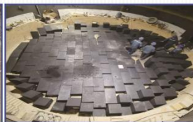
40500KVA电石炉底碳砖砌筑施工
