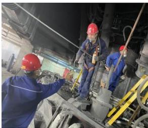
截止目前，已经完成碳材输煤皮带通廊顶部四周安装防护栏、气烧窑各岗位重新制作安装楼梯和加宽铺设气烧窑导热油平台跨管道、线槽过梯。“输煤皮带房顶四周防护栏一安装，我的心终于放下了，之前真怕夜班巡检的时候掉下去”“我们这边的楼梯改造真的是改到我心坎上了，以前楼梯太陡，下雨的时候我可吃过亏，屁股都擦破了”“以前导热油平台跨管道、线槽过梯设太窄，每次巡检路过稍有不慎都会被绊倒，现在好了，不用担心摔倒在一堆热管道中了”……这些都是来自各岗位的后期反馈。职工的认可，是这支攻关队加足马力整改余下隐患的不竭动力。
